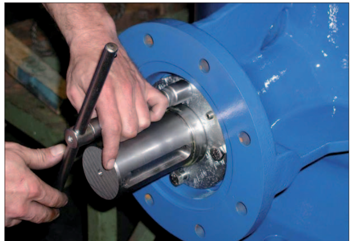
рис. 14: Замена уплотнения - шаг 2
